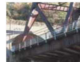
耐候性鋼材を使用した橋梁
