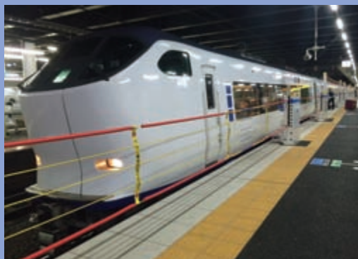
昇降式ホーム柵（高槻駅）
