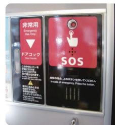
車内非常ボタン
